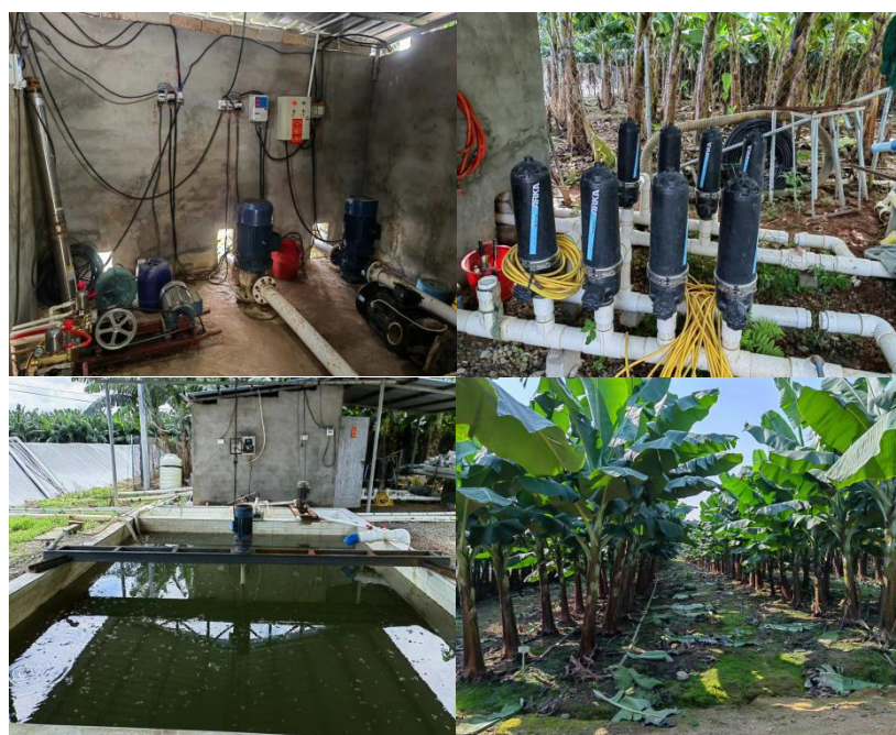
图 2 水肥一体化示范点电机及水泵（左上）、过滤器（右上）、配肥池及搅拌机（左下）、微喷带（右下）
